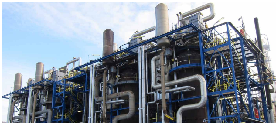
Die vier Reaktoren der POX-Vergasungsanlage bei Yara Brunsbüttel
